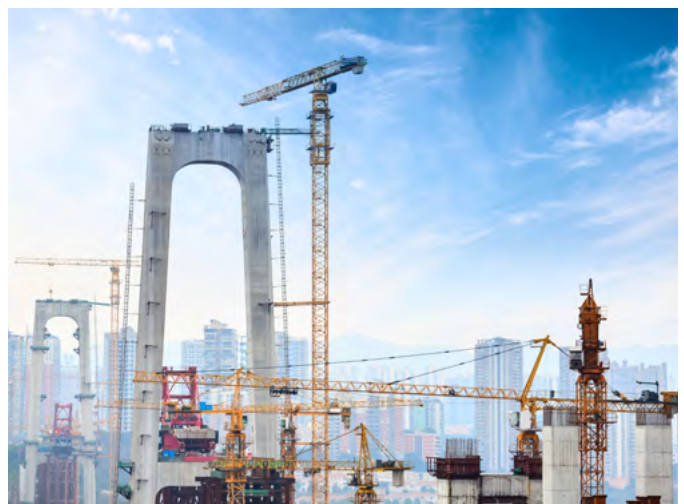
Kran ved bro konstruktion
